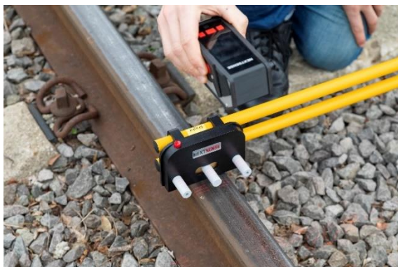
Messung des rechten Schienenprofils
